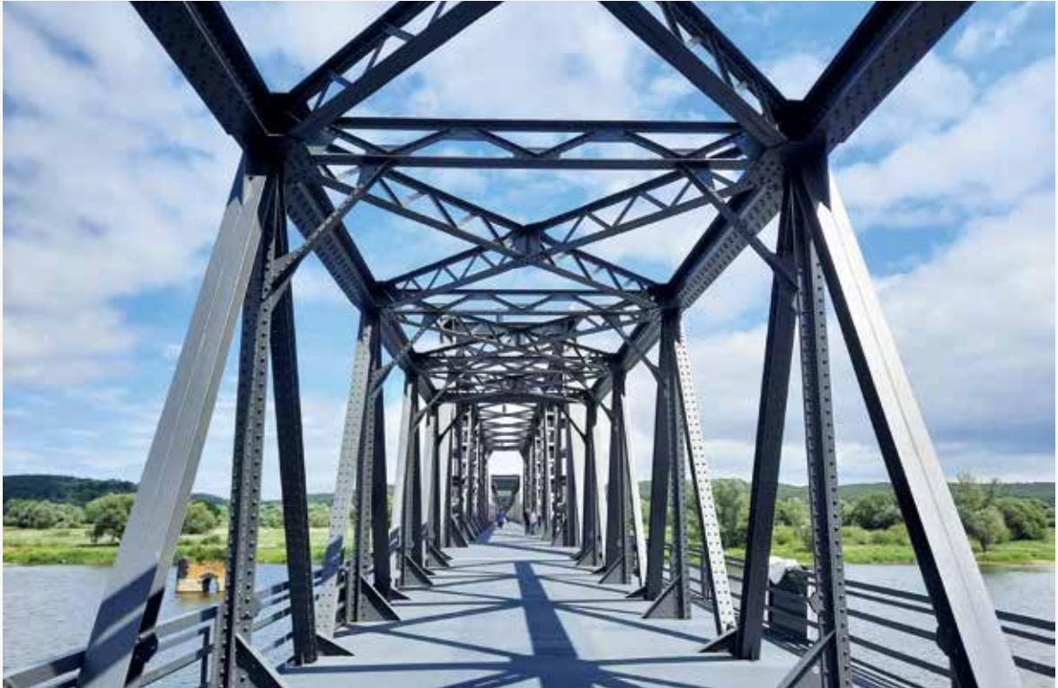
Die Europabrücke Neurüdnitz-Siekierki verbindet seit 2022 Deutschland und Polen.
