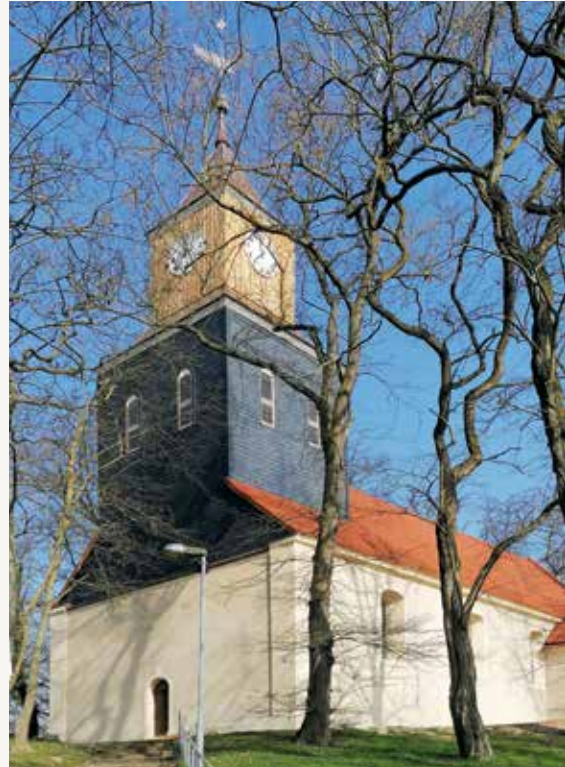
Die frisch sanierte Kirche in Greiffenberg.
