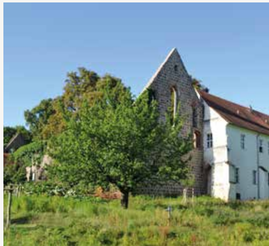
Giebel des ehemaligen Dormitoriums.
